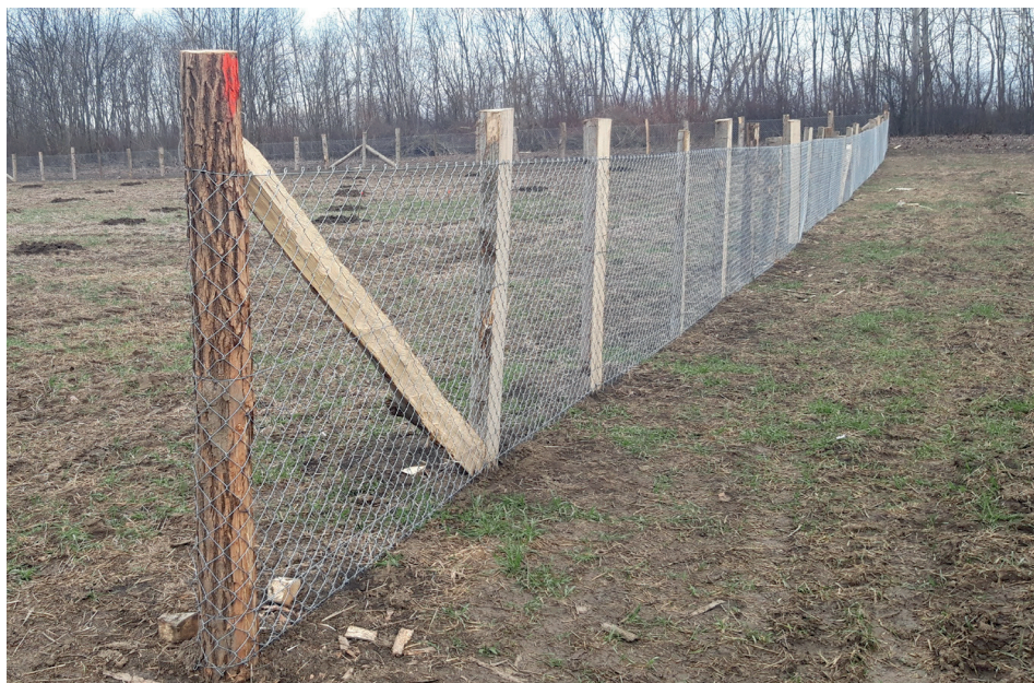
Слика 6. Ограда од плетене жице Figure 6. Woven wire fence
