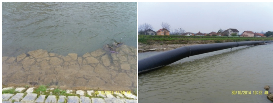
Слика 4. Дно корита реке Колубаре и оштећен магистрални цевовод (фото: А. Анђелковић)
