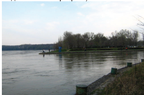
Слика 2. Канал ДТД код водозахвата Бездан
