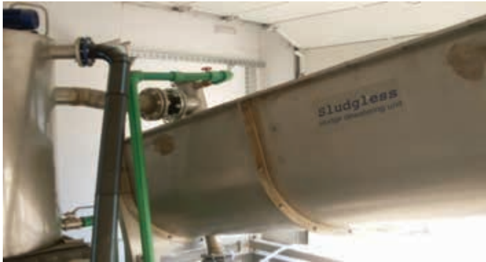
Слика 11. Машина за мљење и мешање муља са полиелектролитом и када за пресовање (фото: Н. Милошевић, 2013)
