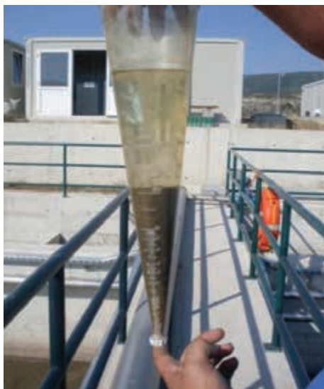
Слика 9. Мензуре за контролу количине муља (фото: Н. Милошевић, 2013) Figure 9. Cylinders to control the amount of sludge (photo: N. Milosevic, 2013)
