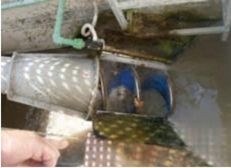
Слика 4. Почетни део пужног система у базену са финим ситима. (фото: Н. Милошевић, 2013)
