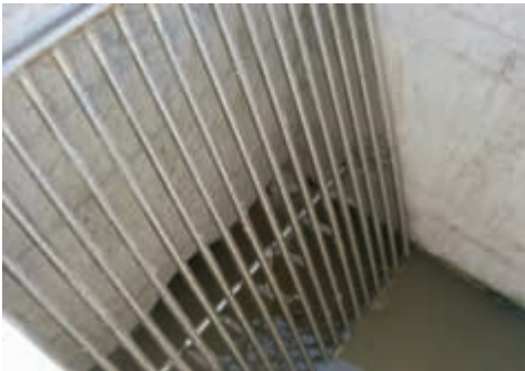
Слика 2. Изглед решетке за заустављање кабастог и пливајућег отпада (фото: Н. Милошевић, 2013)
