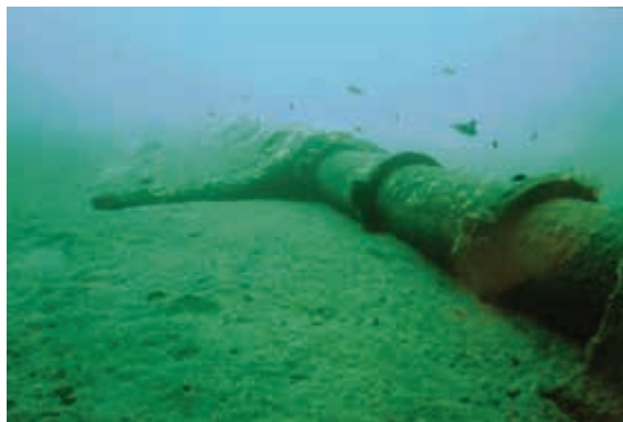
Слика 10. Цевовод за испуштање пречишћених вода по дну језера, оптерећен теговима у циљу спречавања испливавања на површину (извор: ронилачки клуб Билећа)
