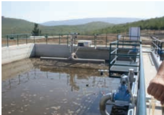
Слика 8. Декантер ван биоаерационог базена (фото: Н. Милошевић, 2013) Figure 8. Decanter outside the bioaeration pool (photo: N. Milosevic, 2013)
