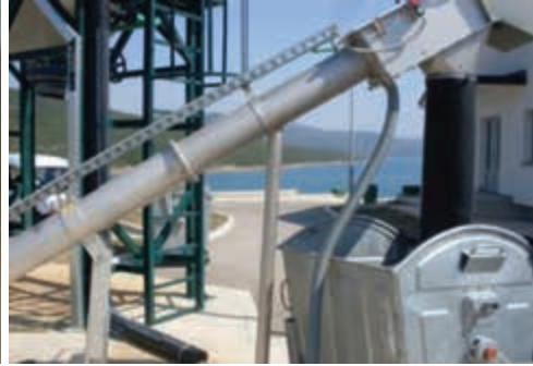
Слика 5. Завршни део пужног система са контејнером у којем се одлаже нагомилани муљ. (фото: Н. Милошевић, 2013)
