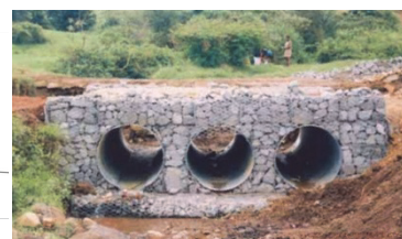
Слика 10. Заштита цевстих пропуста Figure 10. Protection of culverts
