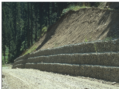
Слика 2. Габионски потпорни зид на шумском путу Figure 2. Gabions retaining wall on forest road
