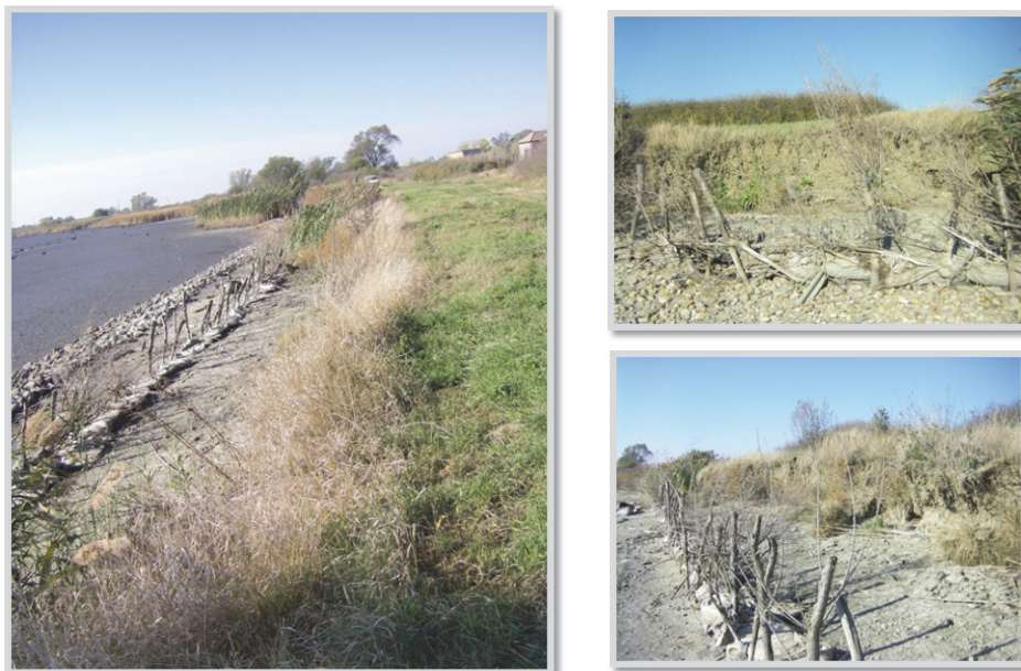
Слика 2. Оштећење насипа на рибњаку „Вршачки ритови” Figure 2. Damage of carp farm bank “Vršачki ritovi”
