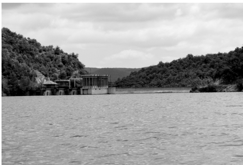
Слика 1. Брана и водозахват хидроакмулације "Грлиштије" (Фото З. Никич) Figure 1. Grlišće Dam and intake chamber (Photo by Z. Nikić)
